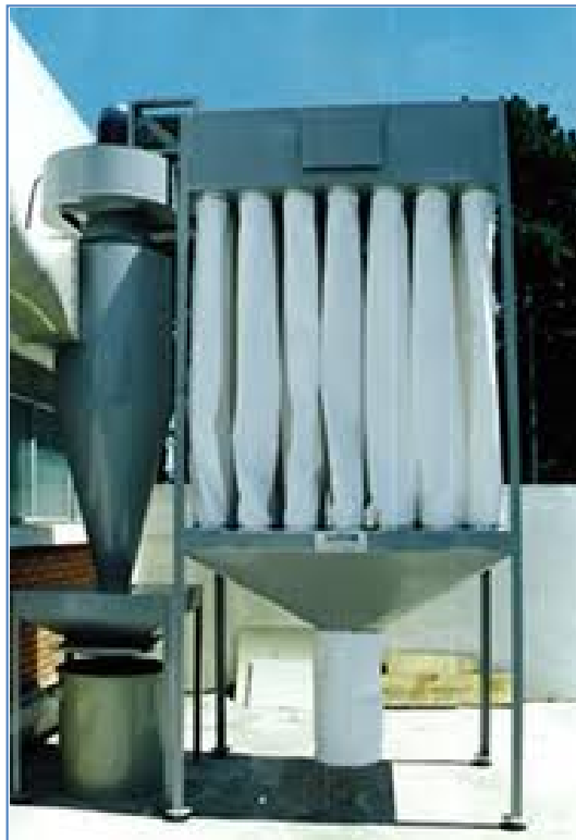
Figura 3. Sistema de Exaustão por filtros de manga
